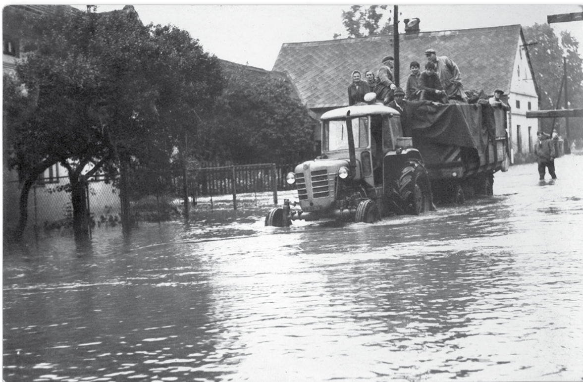
Velká voda na hlavní cestě poblíž autobusové zastávky v Malé Košatce v červenci 1966 před chalupou č. p. 60. Dojičky jedou z práce z kravína v Malé Košatce.
