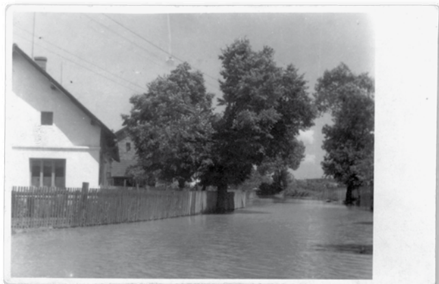
Povodeň v červnu roku 1954 na cestě před chalupou č. p. 48.
