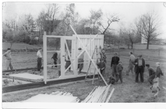
Výstavba „kuřína“ drůbežárny v letech 1958–1959. Fotografii zapůjčil pan Luděk Tůma.
